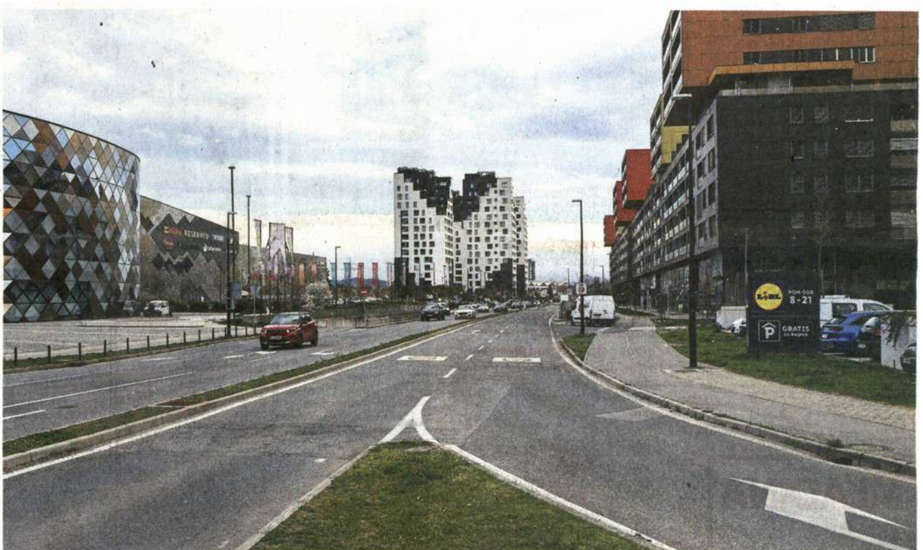
Šiška ostaja polna nevarnih prometnih točk. Kritično je predvsem križišče Celovške ceste in Rakuševe ulice (na fotografiji), kjer so najbolj ogroženi pešci in kolesarji.
